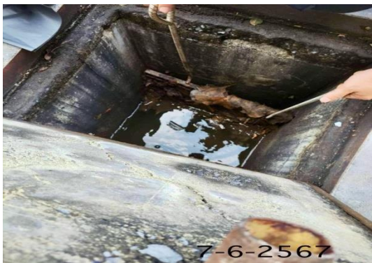
ภาพที่ 12 ตะแกรงคัดขยะที่ Man Hole สุดท้าย
